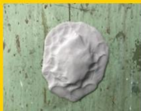
金属タンク補修
