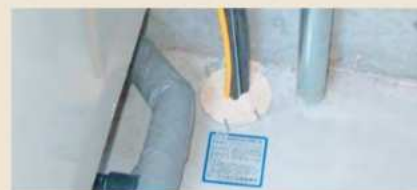
PS060FL-0113工法 施工例
