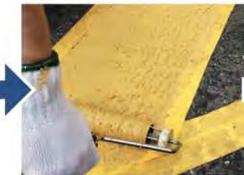
専用のローラーを用いて塗布面にパターン(凸凹)付けし、仕上げます。
