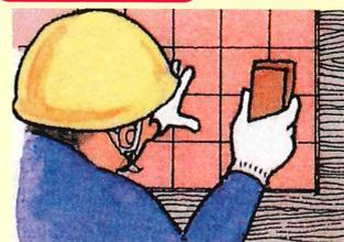
直ちにモミ込むように張付け、タタキ板等で十分に押さえてください。時々1~2㎡ごとに貼付けたタイルを剥がし、タイル裏面への接着剤(つくピタ)の付着が充分あることを確認しながら張り進めてください。
