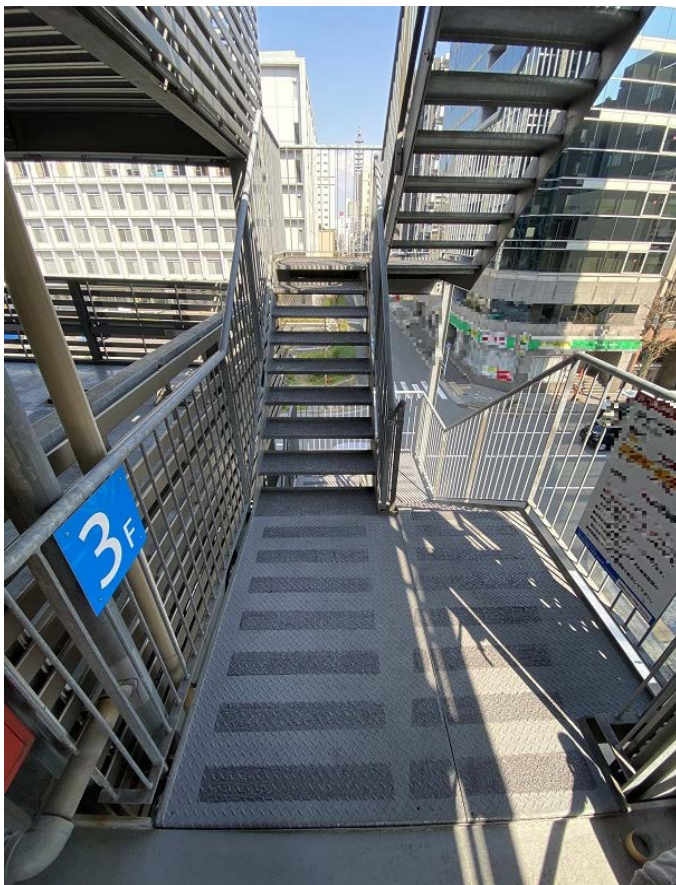
[写真-14] 塗工完了。
