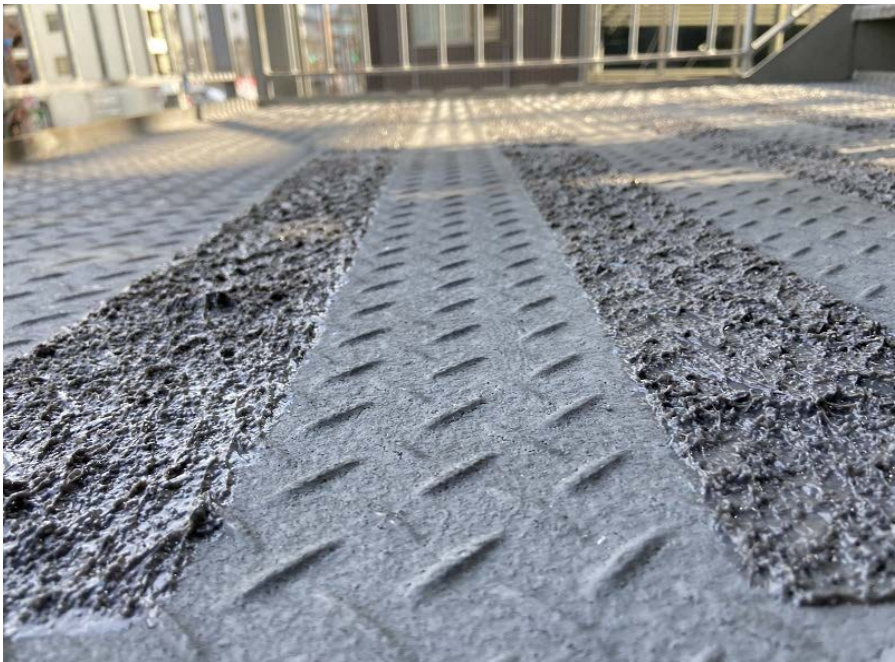
[写真-12] すべり止めコート塗工完了部の 拡大画像
