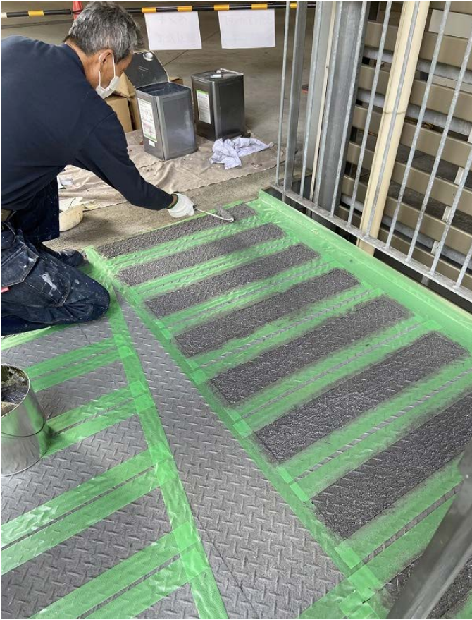
[写真-7] 塗作業 3階踊り場。
