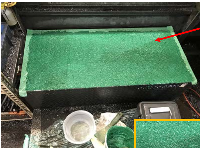
[写真-4] ヘラを用いて、すべり止めコートを薄く塗布。
