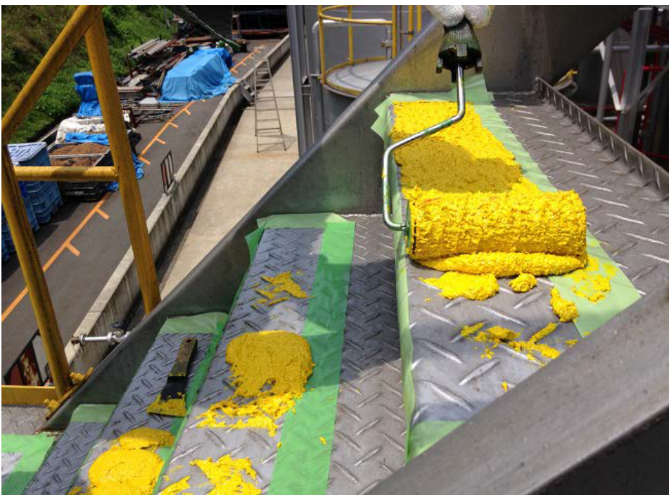
[写真-5] 塗布方法； 任意の量を塗布面に置く。 次に、専用ローラーで樹脂を 塗り広げてゆく。
