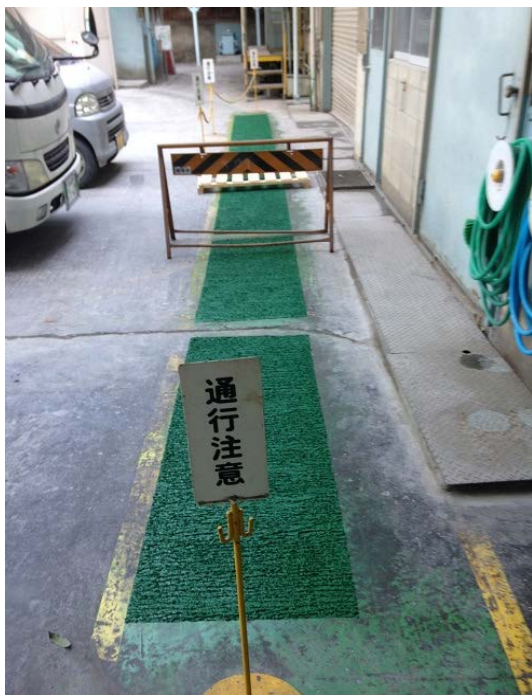
[写真-4] 施工直後
