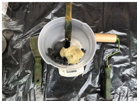
[写真-3群] すべり止めコートを小分けする際には、 主剤：硬化剤＝9：1 の割合で秤量する。
