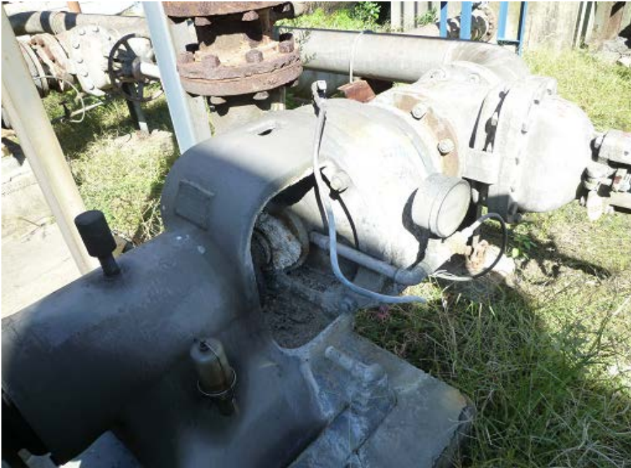
[写真-1] 10年以上稼働している 工業用水ポンプ
