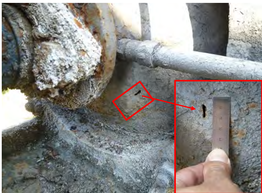
[写真-2] 長年の使用により、内部から摩耗 減肉して貫通穴が開いている
